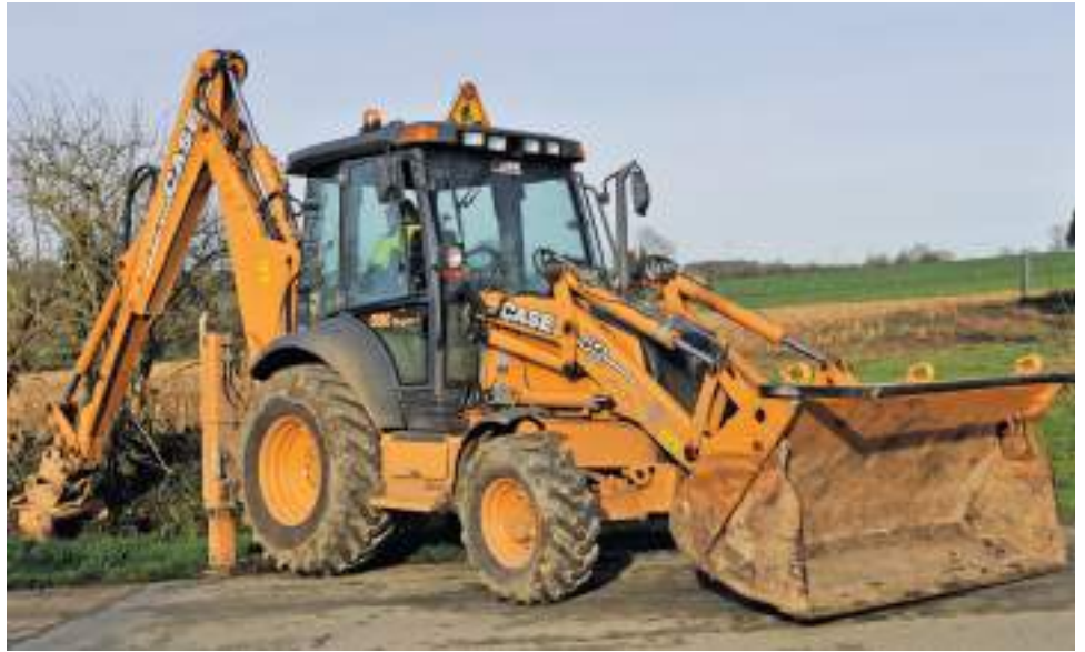
Curage d'un fossé Rue de Kervoastellou.
